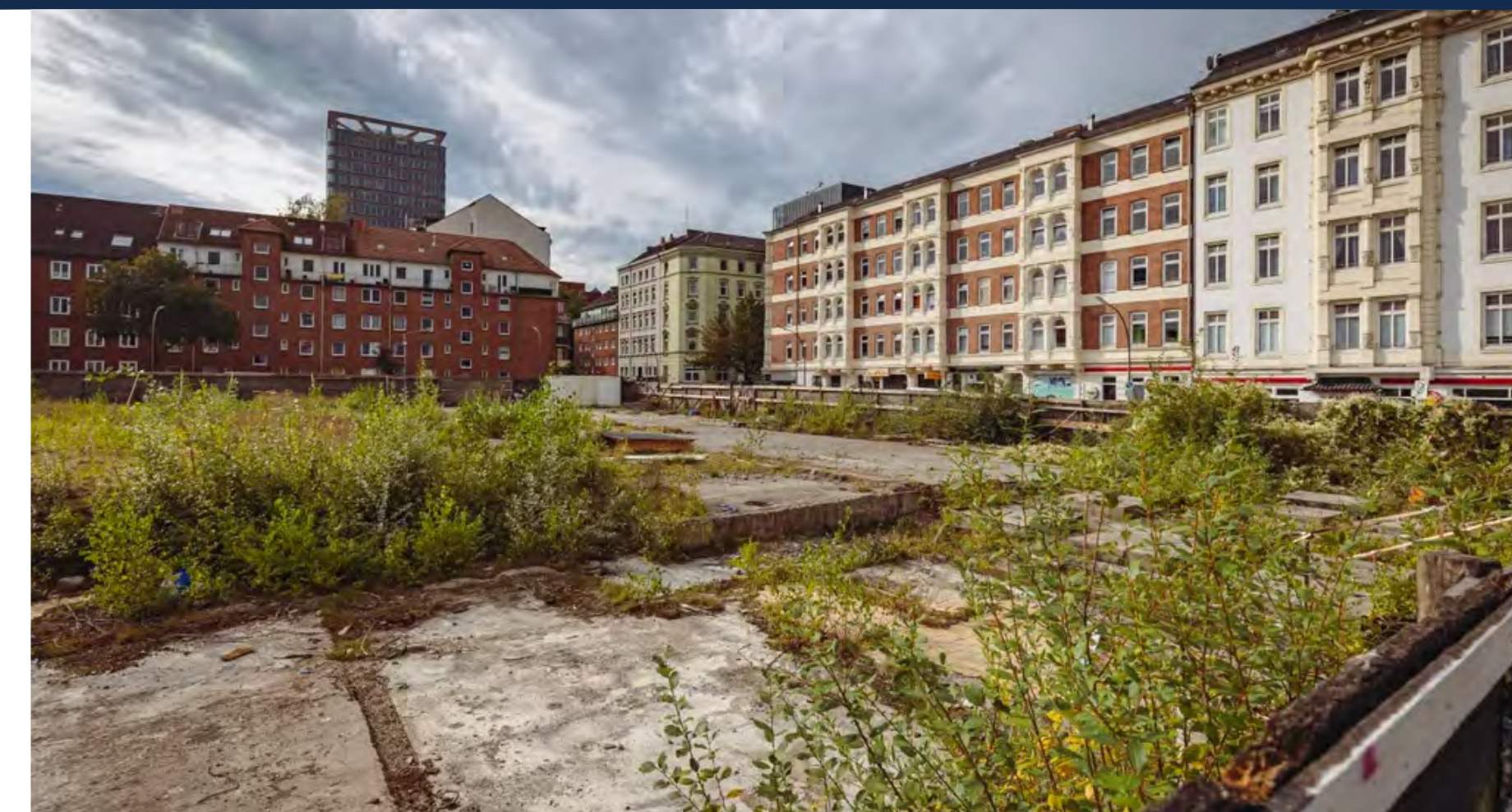
Das Grundstück der ehemaligen Essohäuser ist bereits seit Februar 2014 verwaist.
